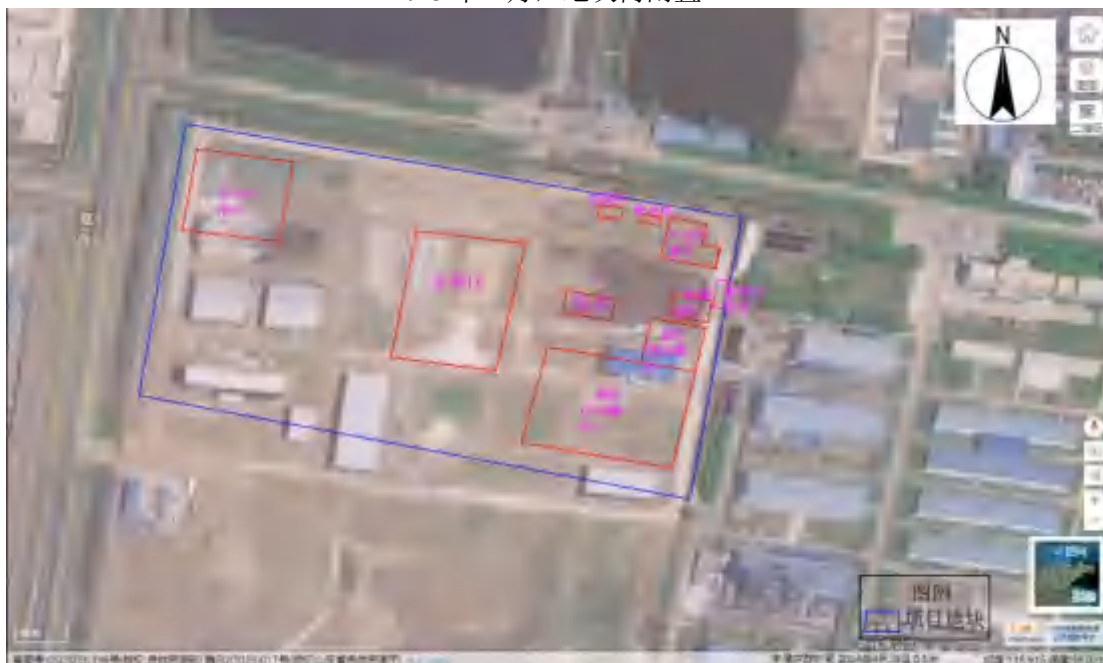
2024 年 4 月，新建建设了 5 座车间和 1 座办公楼及配套用房（均未完工）
