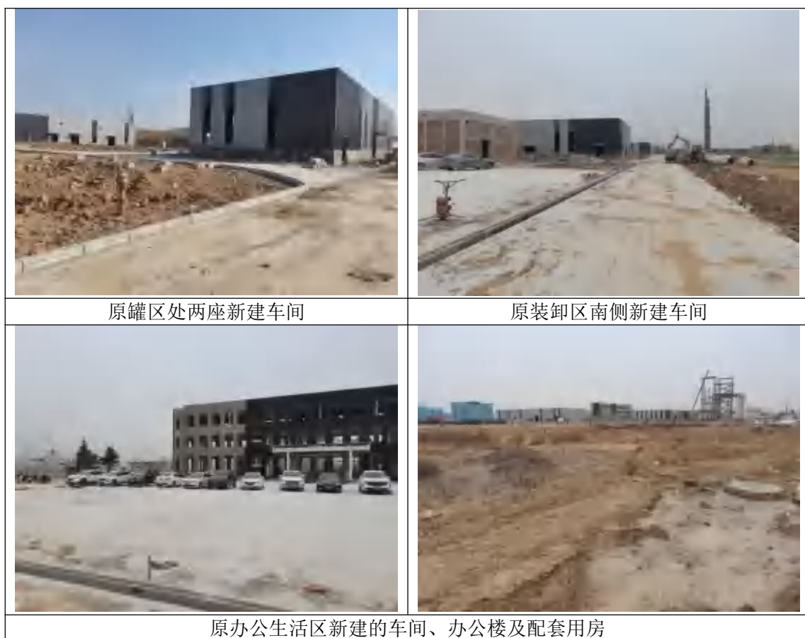
图 3.6-5 现场踏勘照片（5）
