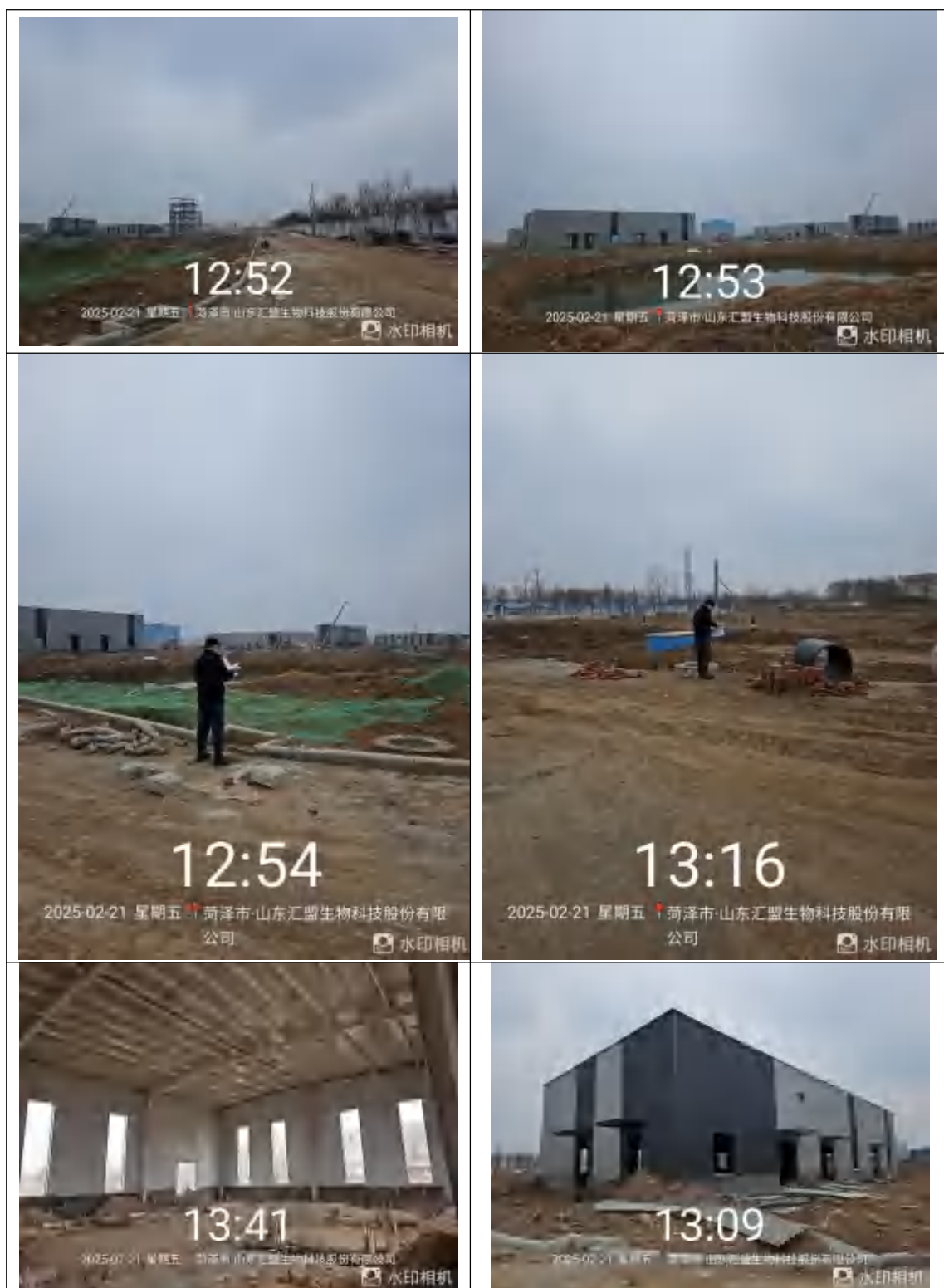
图 3.6-1 现场踏勘照片（1）
