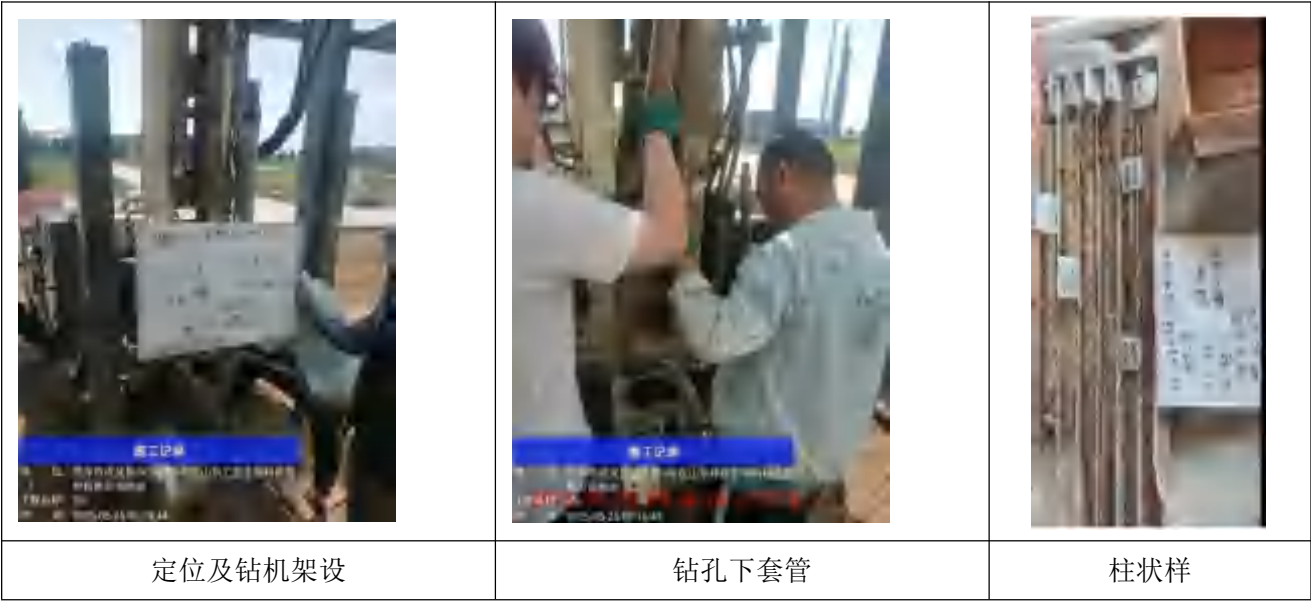
图 5.1-1 钻机现场采样照片
