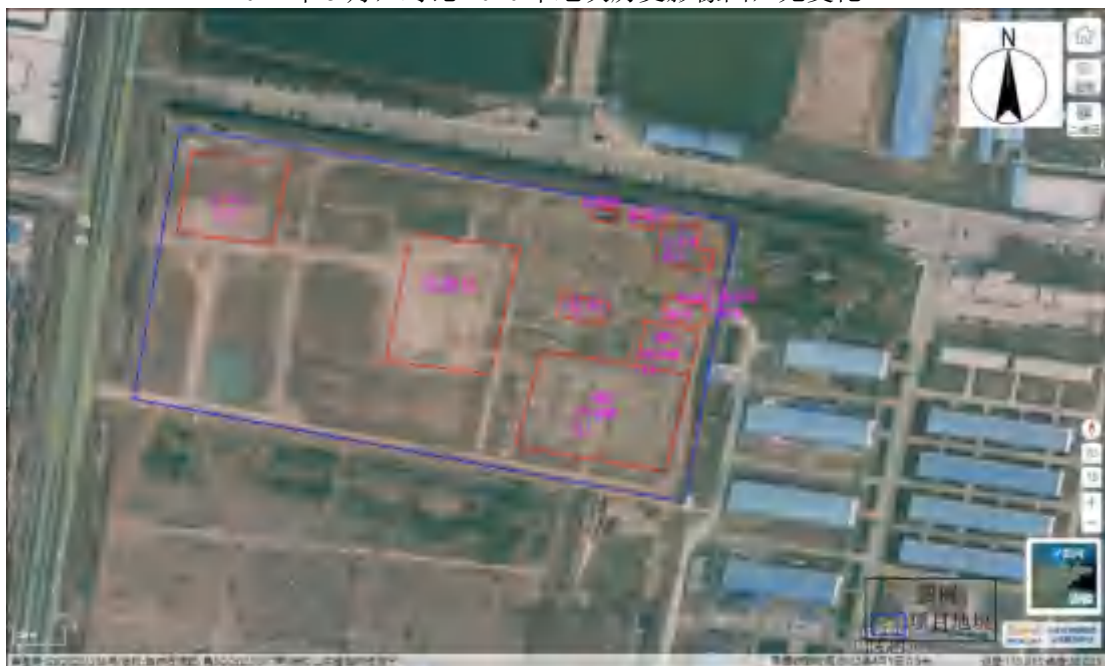
2022 年 4 月，地块内构(建)筑物已全部拆除完毕。
