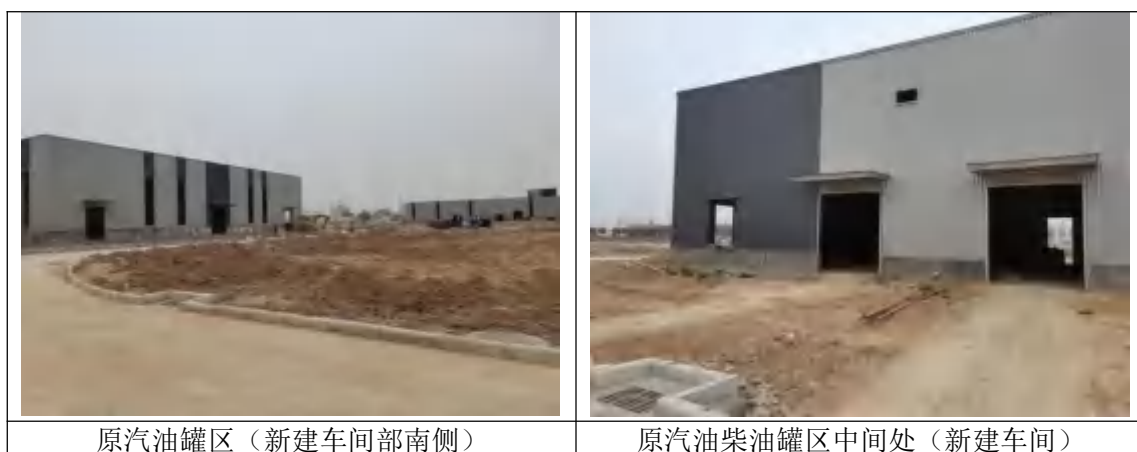
图 3.6-3 现场踏勘照片（3）
